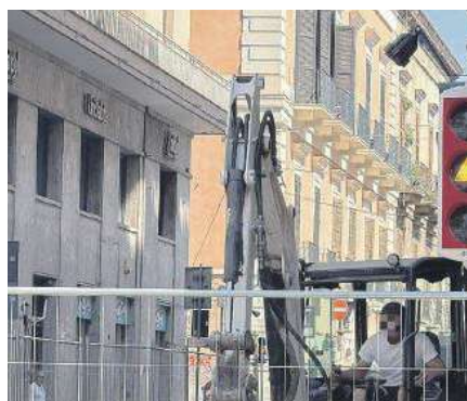
Lavori per il nuovo sistema di trasporto Bus rapid Transit in via Andrea Da Bari
